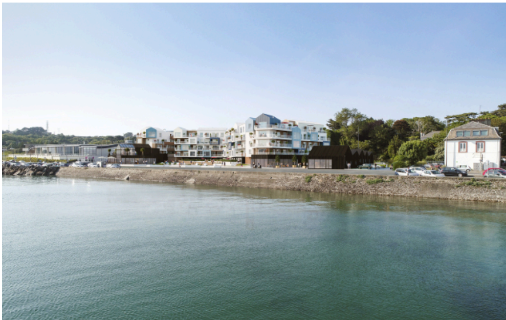
La résidence Rosalie abritera 48 logements de standing le long de la plage du Moulin-Blanc, près de Brest — Photo : Océanic Promotion
